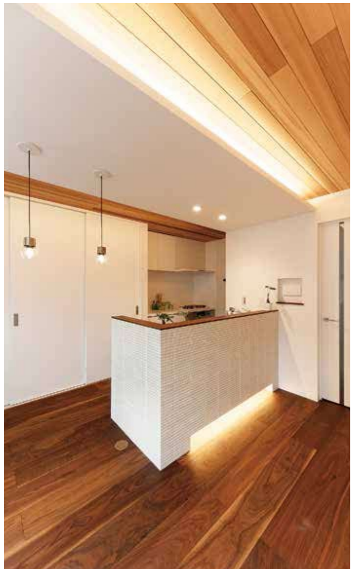
カウンターの足元を間接照明がライトアップ。照明器具の設置場所や、木とタイルの異素材が切り替わる箇所の取り方など、ディテールが精巧。見学の必見ポイントだ
