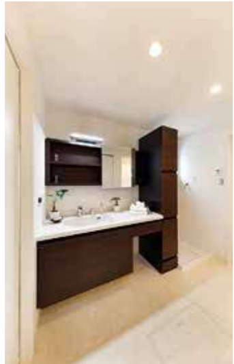
水廻りは集めて、ホテルのパウダールームのような動線に。見えない箇所配管まで美しく
