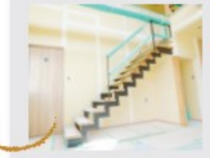
⑪階段 一番のこだわりがこの階段！鉄骨をオーダーで加工し作ったストリップ階段。光と風をしっかりと通し、インテリアのアクセントにもなる階段です。
