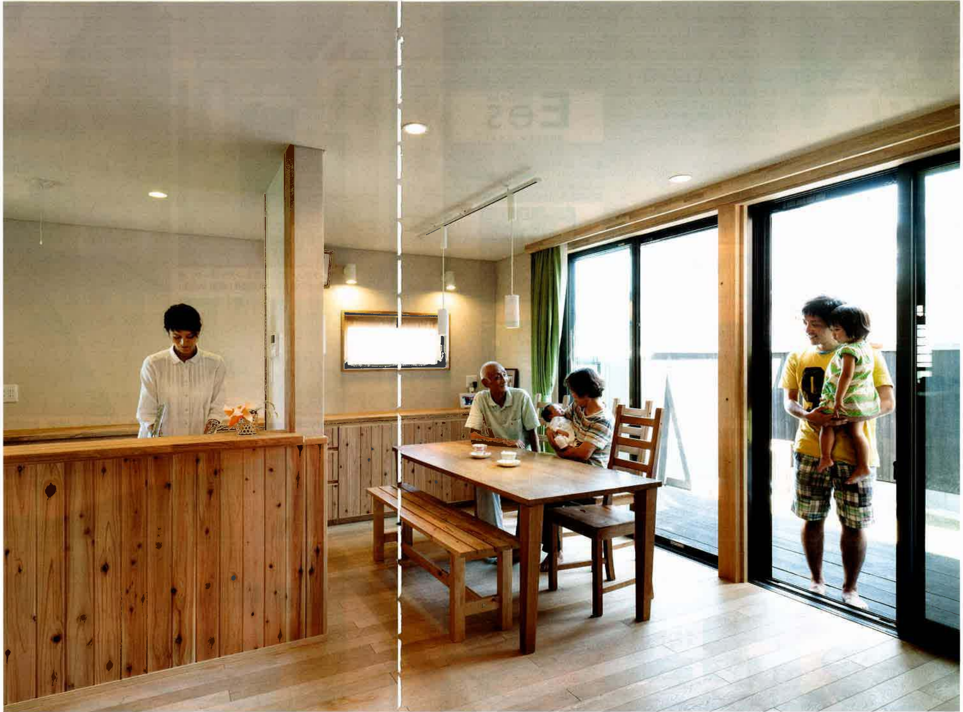
無垢の床、珪藻土を塗った壁に腰板を貼ったナチュラルなLDK。ダイニングテーブル奥のカウンター下にカッボードを造作。開き戸や引出しなどをていねいに作り上げた。デッキにもつながる開放感のある空間に(設計/moda architects + 北岡慎也 見開きページはすべてS氏邸)
