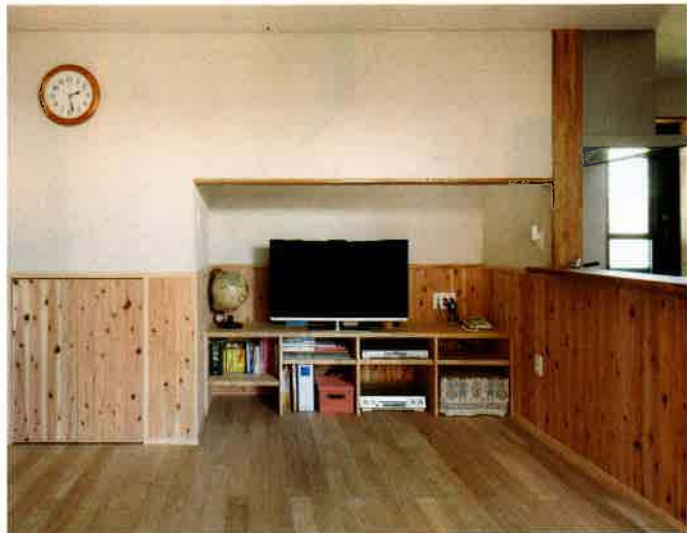
TVボードも無垢材で造作。垂れ壁になっているのは、階段による勾配天井を見せない配慮。垂れ壁奥にも窓が設けられ、ここからの涼やかな風がLDKを吹き抜けていく
