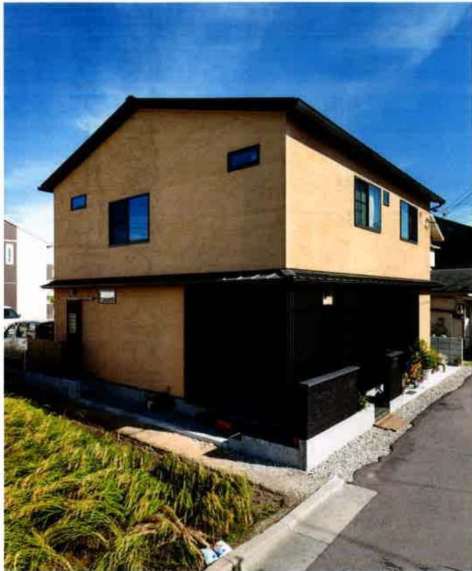
楕円が美しい塗り壁の外観。深みのある黄土色の壁は光によって、様々な表情を見せる。ファサードの黒い棧と組み合わせて、京都の町家をイメージさせる雰囲気
