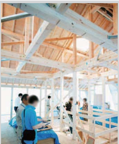
月に1度のペースでコンスタントに開催される「構造見学会」(写真)や「完成現場見学会」。SE構法が叶える開放感や、通気断熱WB工法による快適な室内環境を確認しよう
