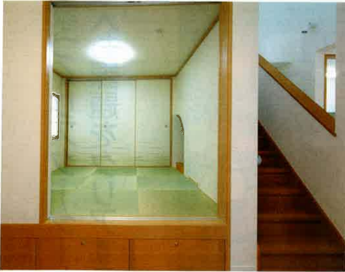
和室は40cm高い床に設計し、立体方向にも広がりを感じさせる工夫が、「こうした希望を全部プランに採り入れていただきました」。建具はすべて大きく開放できる引き戸を採用した
