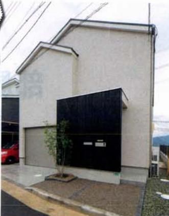
道路からの視線を遮るよう北側に窓のない設計に。南と東に開けた高台立地なので、南・東・西の窓だけで採光・通風ともに十分確保できる
