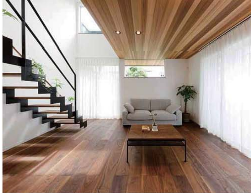
床にブラックウォールナットの無垢材を選び、天井にはレッドシダーを貼って、スッキリとしたデザインの中に自然素材を繰り返し入れて装飾
