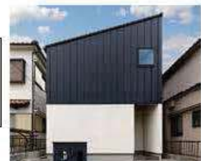
ガルバリウム鋼板 100%ではなくツートンカラーにしたことでコスト削減にも成功
