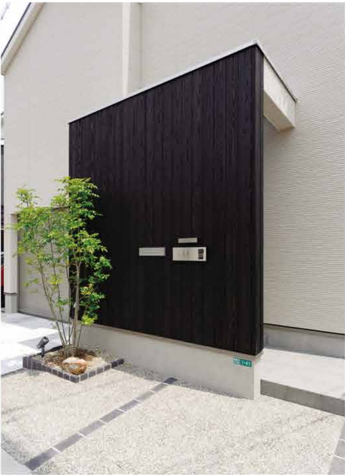
防犯面を考慮し、玄関が外から見えないように飾り壁の目隠しを設置。
