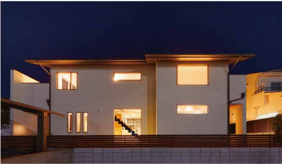
深く迫り出した軒が印象的。縦スリットに横スリットに大開口、窓の形状や配置も特徴的な外観
